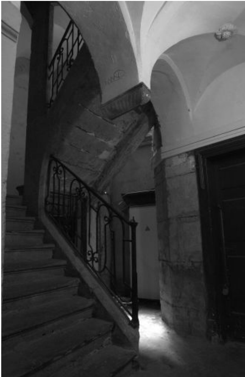
Escalier, vue depuis le palier du rez-de-chaussée
