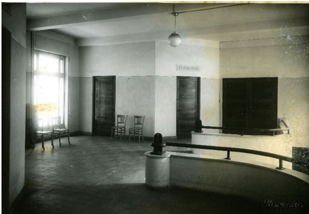
Ancienne entrée des professeurs et de l'administration, photographie ancienne, ca 1945
