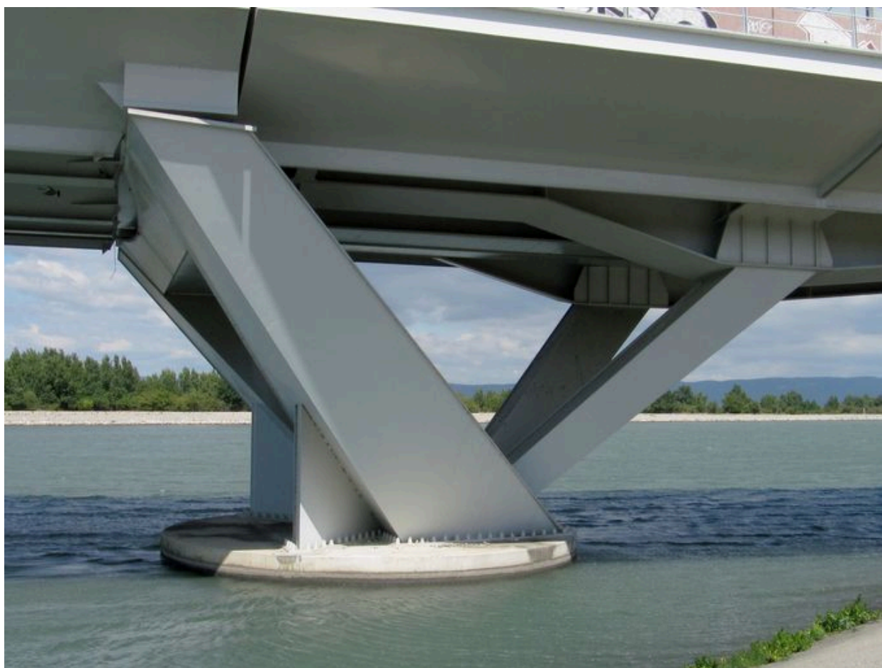
Pile gauche, vue générale, face aval (depuis la rive gauche)
