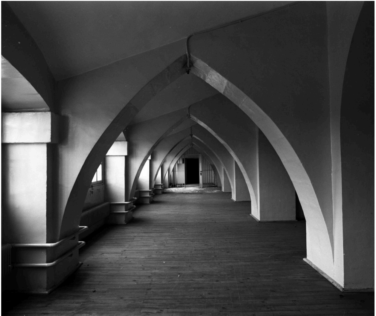
Bâtiment B (église), galerie-haute.
