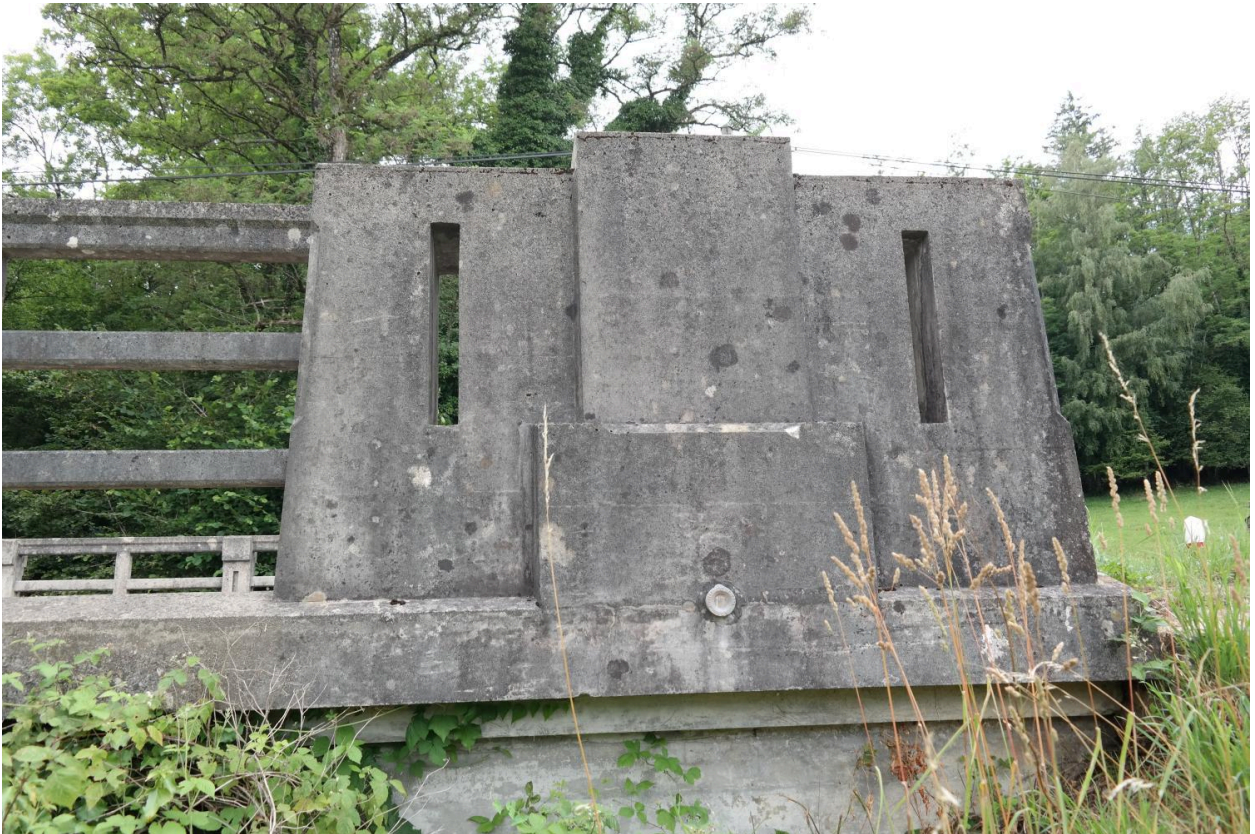
Pont Borian, détail du garde-corps avec borne géodésique
