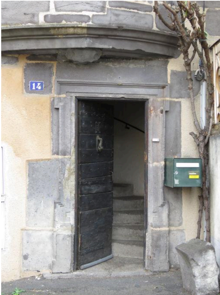
Vue de détail : porte d'entrée
