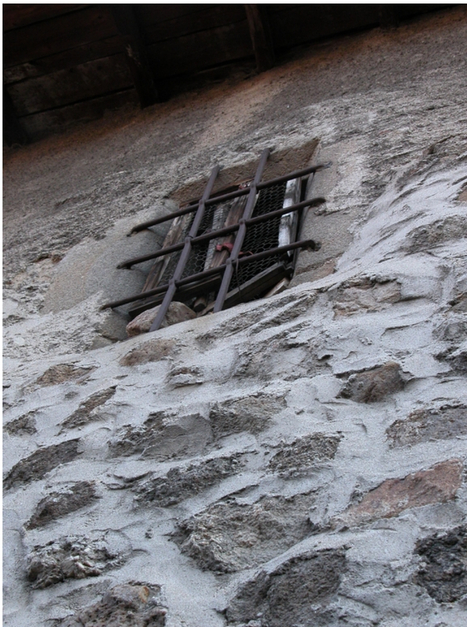
Le Bourg, rue du Syndicat. Ferme, puis maison (1999 AD 112). Détail d'une fenêtre.
