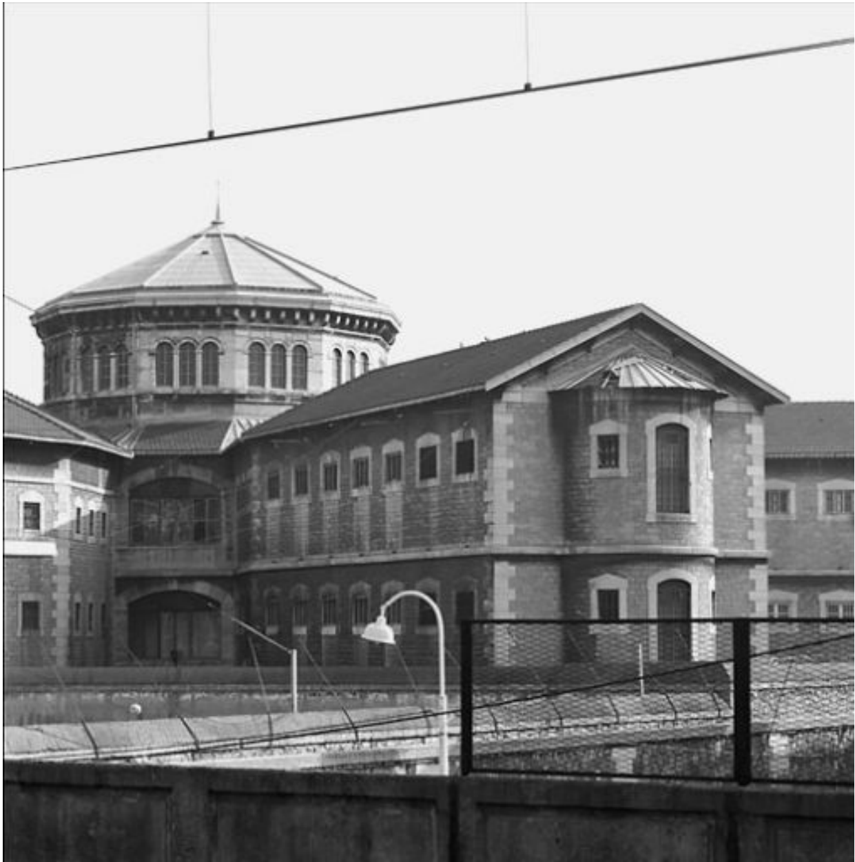
Aile nord et bâtiment central depuis la gare de Perrache
