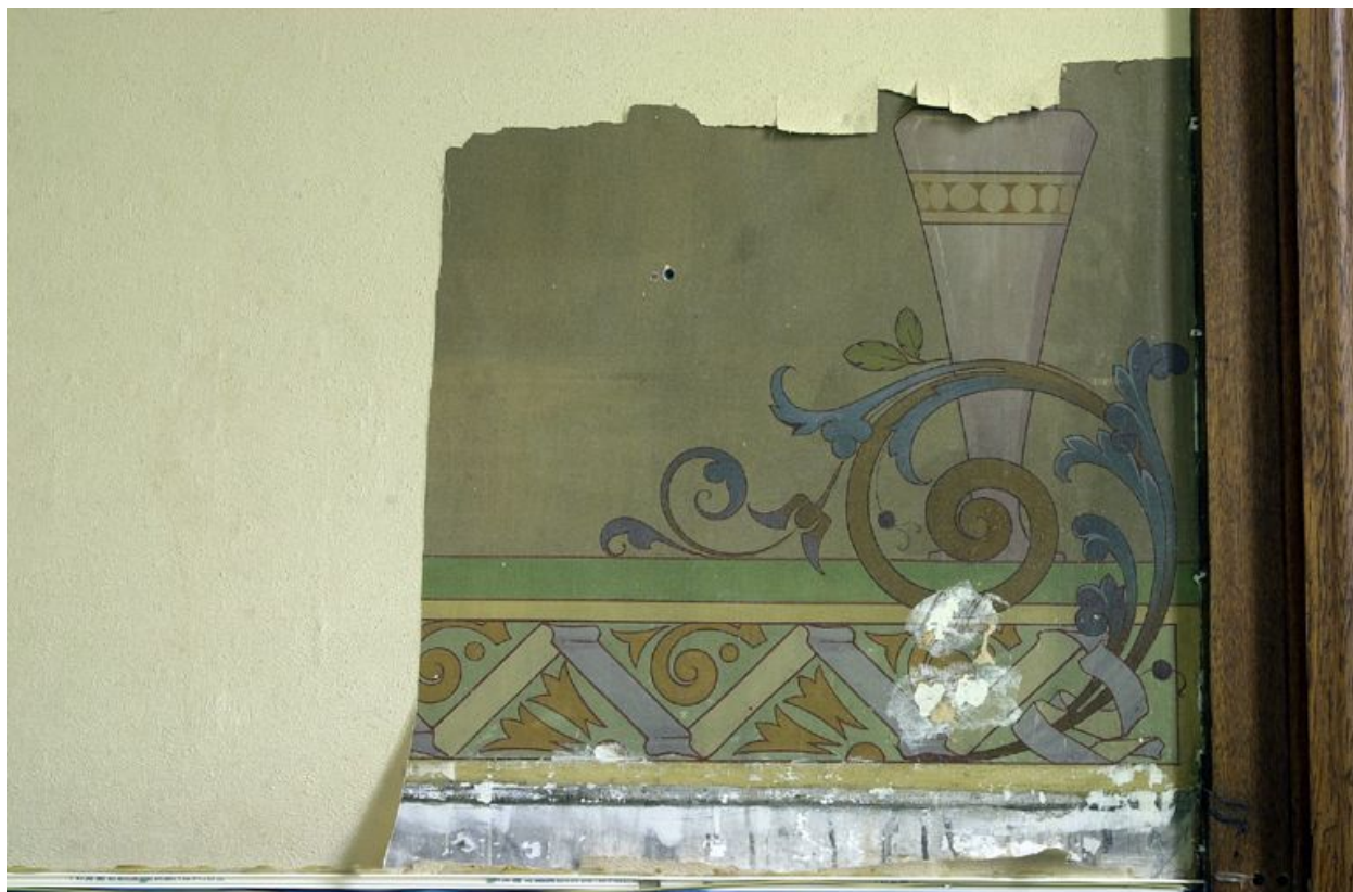
Premier étage : la chapelle, détail de peinture monumentale partiellement mise au jour
