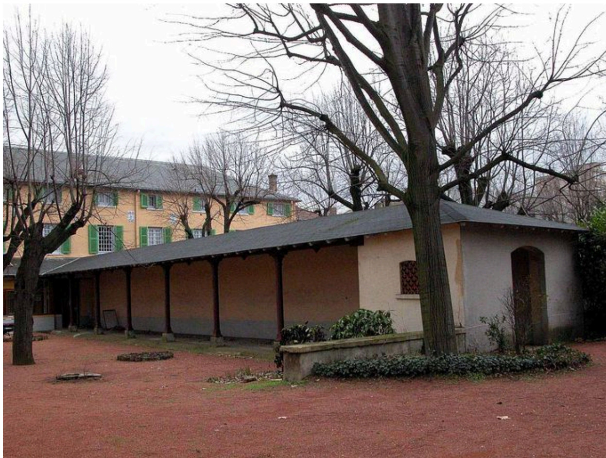
Cour nord-ouest, vue des portiques mitoyens séparant la cour en deux, avant remaniement en 2004
