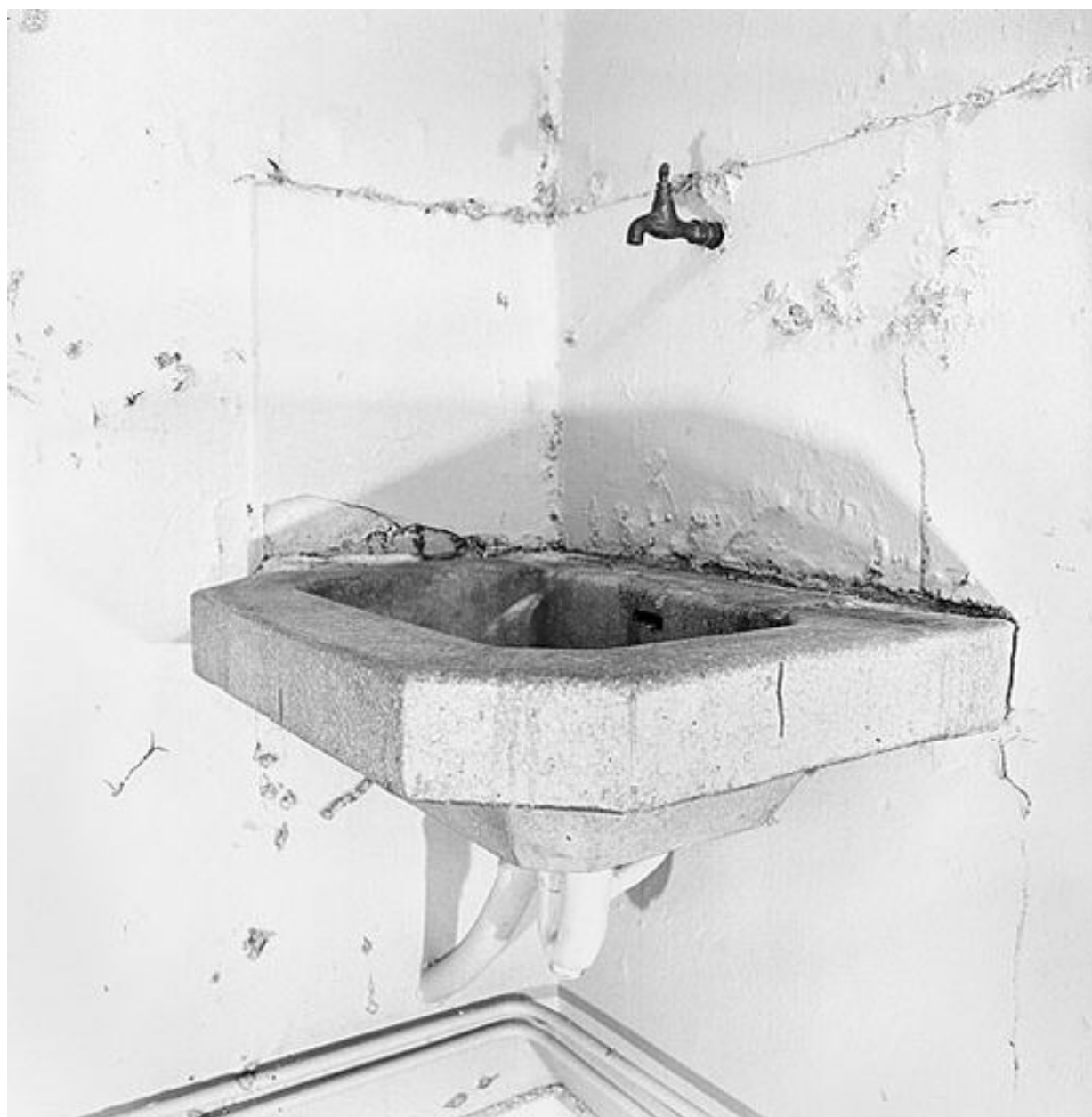
Lavabo, corps de bâtiment central, deuxième étage
