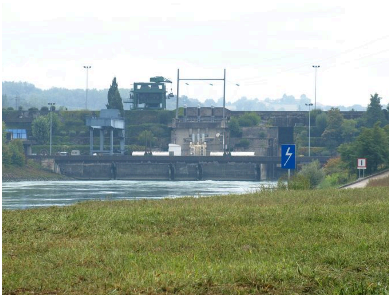
Vue générale de l'usine, côté aval (depuis la rive gauche)
