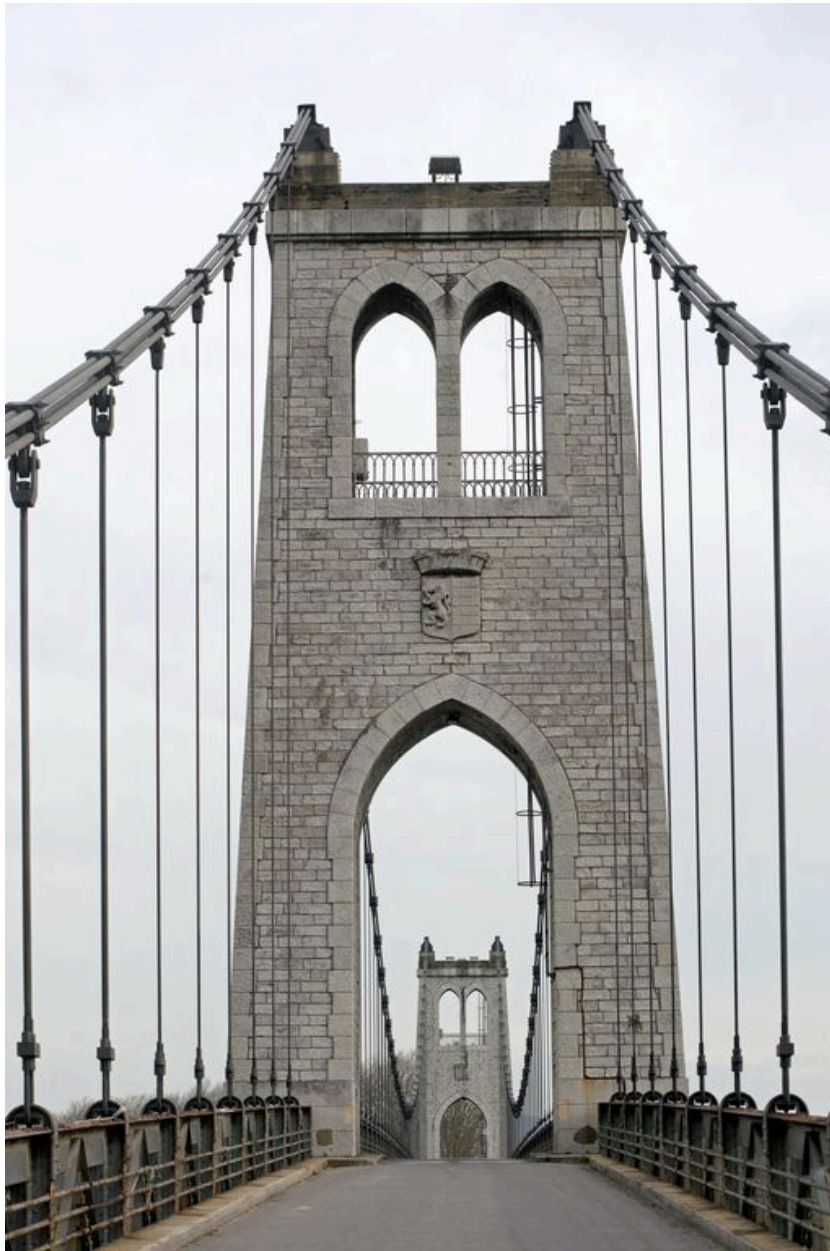
Dessus du tablier et pylône côté La Voulte
