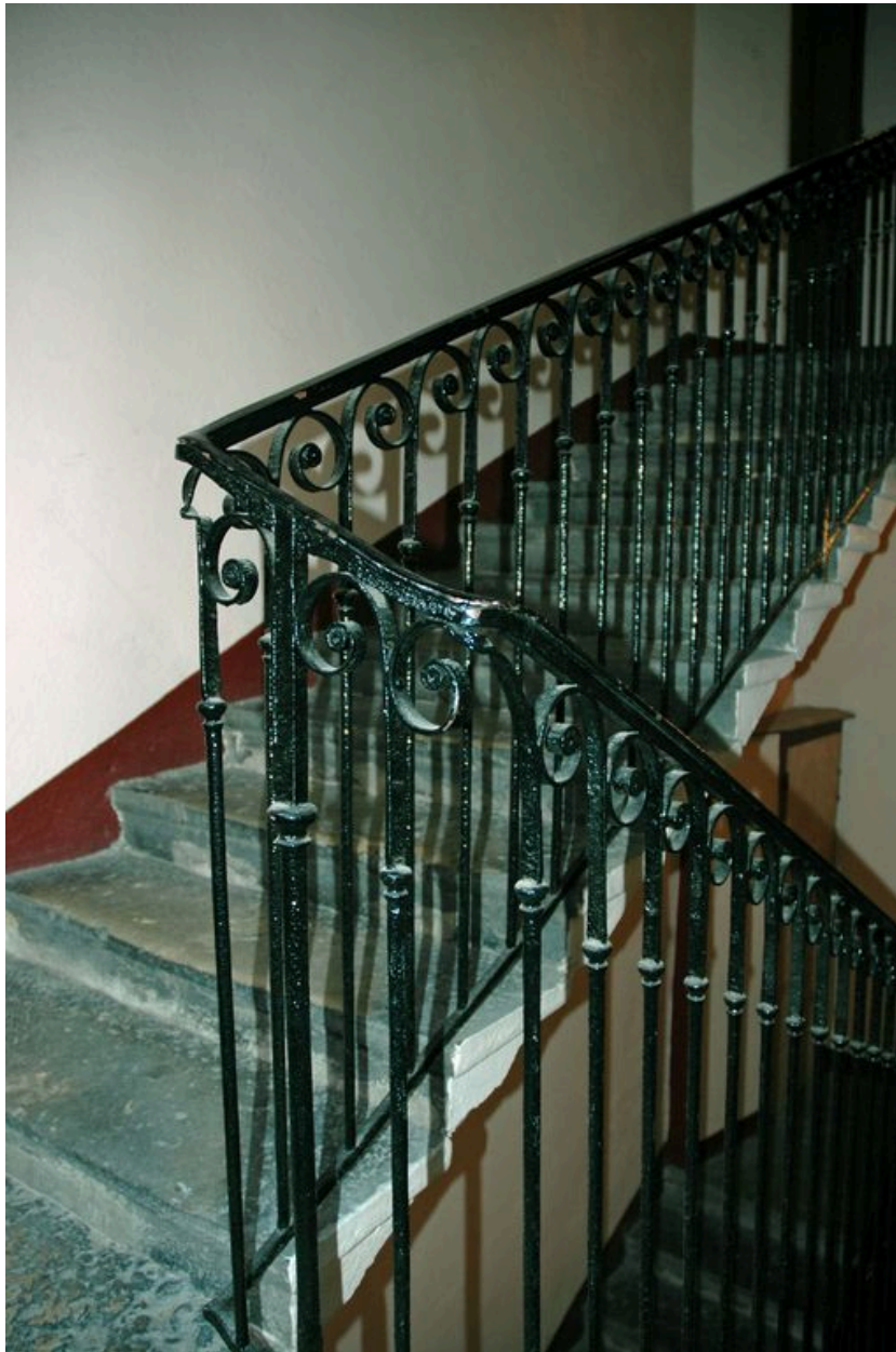
Volées d'escalier en pierre, vue depuis le repos
