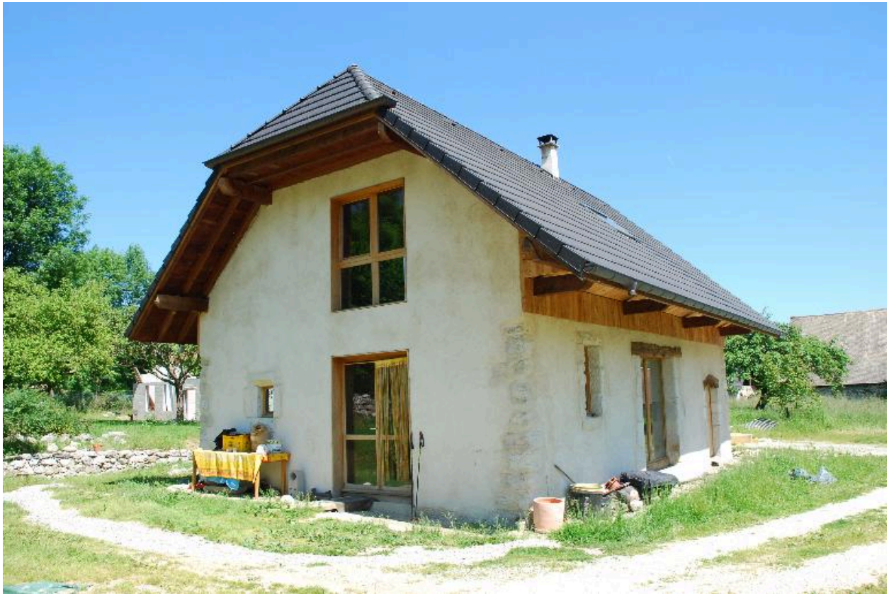
La Plesse, grange-étable (2013 D2 920),vue d'ensemble de trois-quart avant droit.
