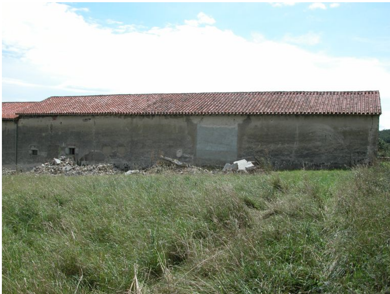
Vue d'ensemble arrière de la grange.
