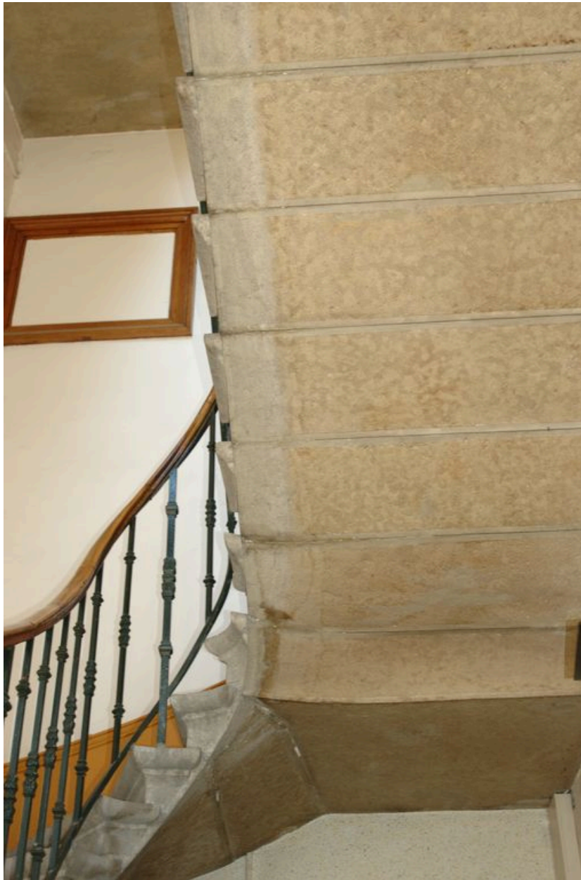
Détail de l'escalier de l'ancien bâtiment de la communauté des soeurs.
