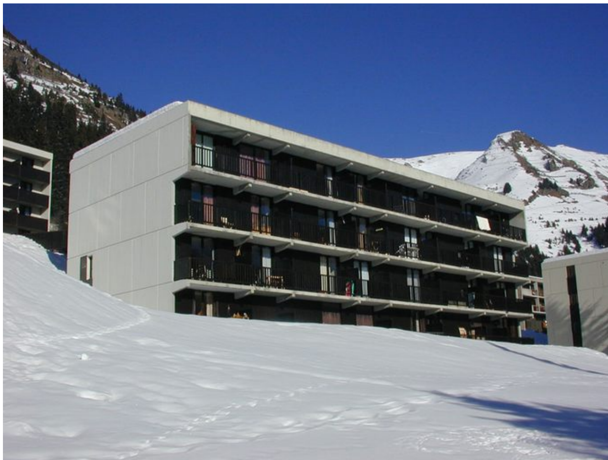
Vue depuis le sud-ouest
