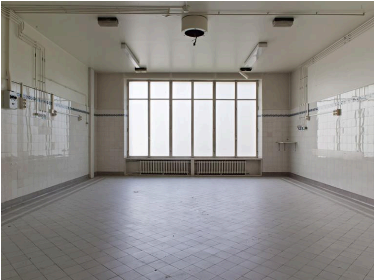
Hôtel-Dieu de Clermont-Ferrand. La polyclinique, salle d'opérations située à l'extrémité orientale du corps de bâtiment arrière (photographie prise de sa limite sud).
