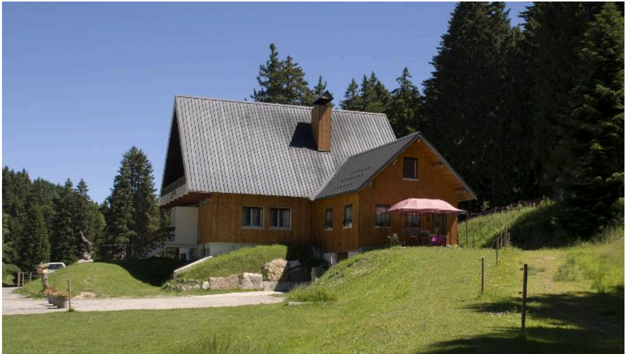
Gîte La Gaillarde : façade sud et extension
