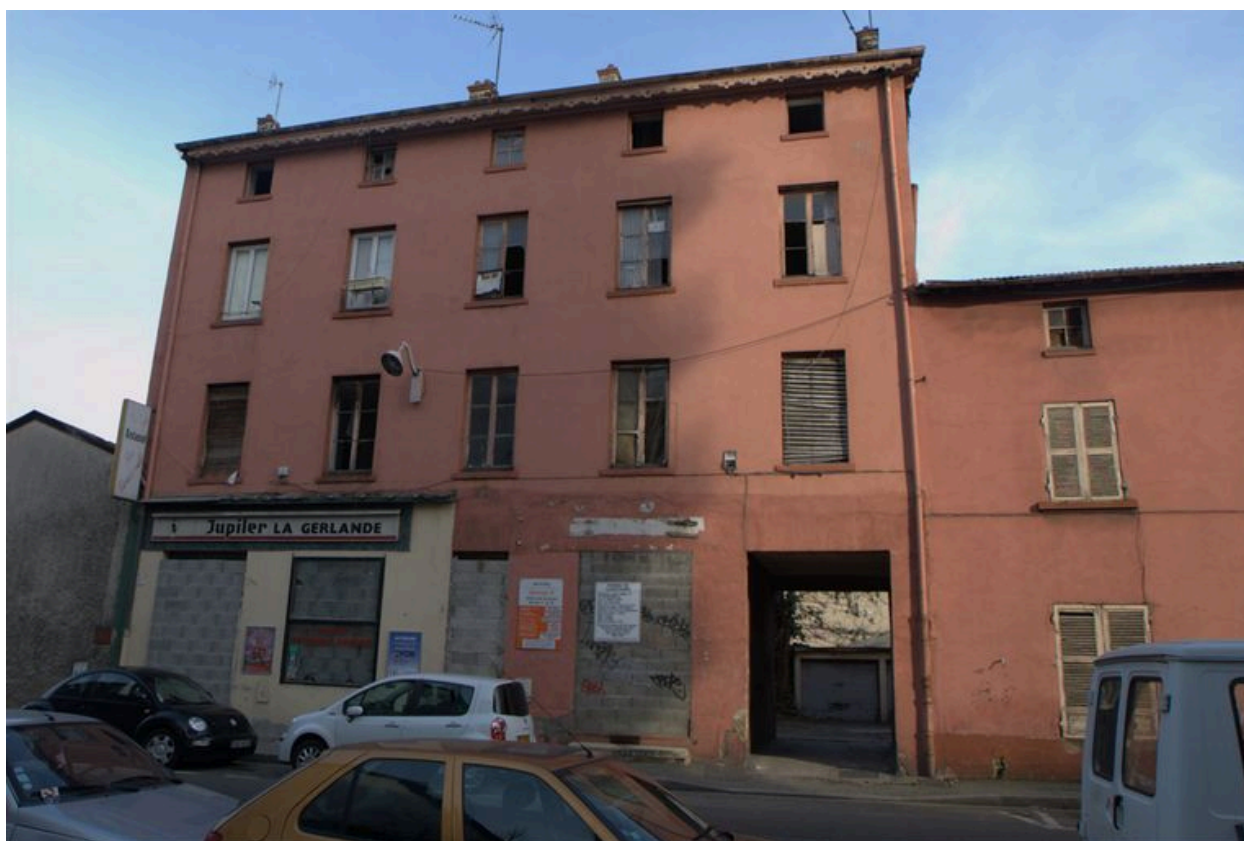
Elévation antérieure depuis l'ouest
