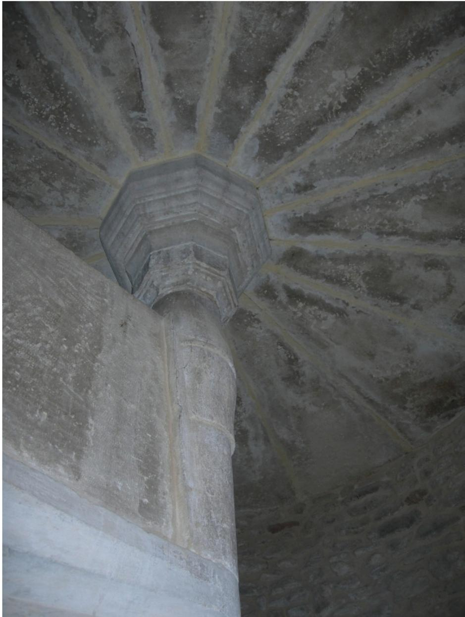
Escalier en vis, détail du couvrement en voûte plate : partie supérieure du noyau et chapiteau moulurés, supportant le plafond dallé rayonnant, sous le dernier étage de la lanterne.
