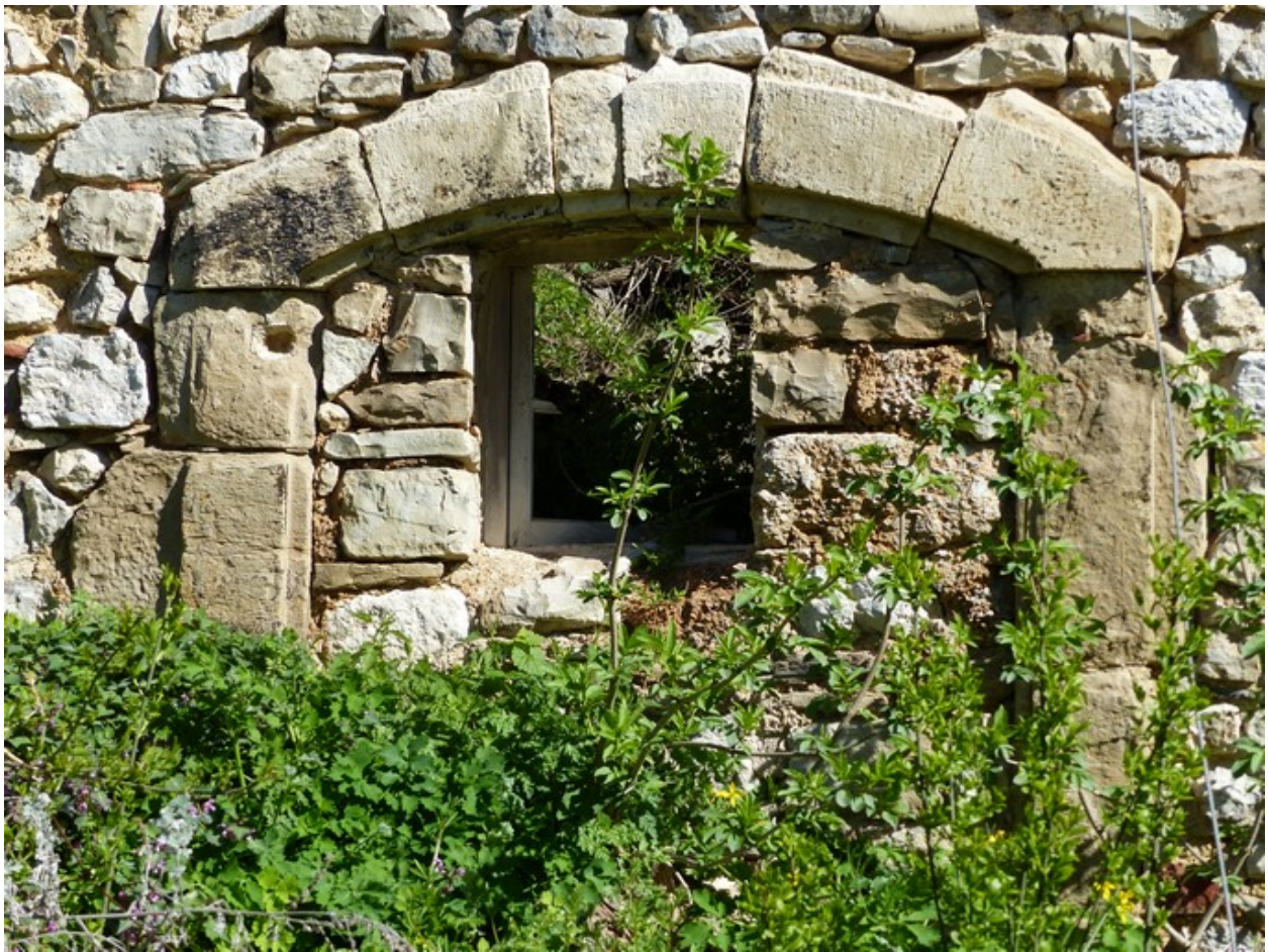
Porte de remise-étable, maison au village.
