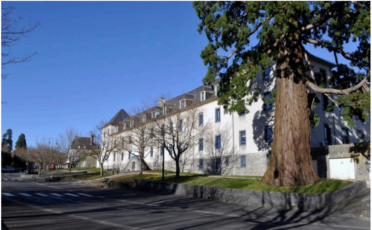
Vue d'ensemble depuis le sud-ouest : élévation principale
