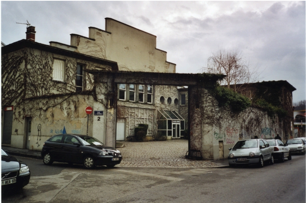
Vue du bâtiment situé au 2 rue de la Fraternité à l'angle de la rue Gorge-de-Loup
