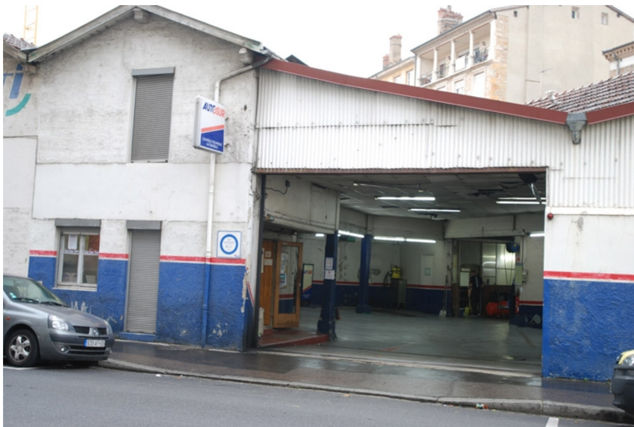
Vue ouest de l'atelier
