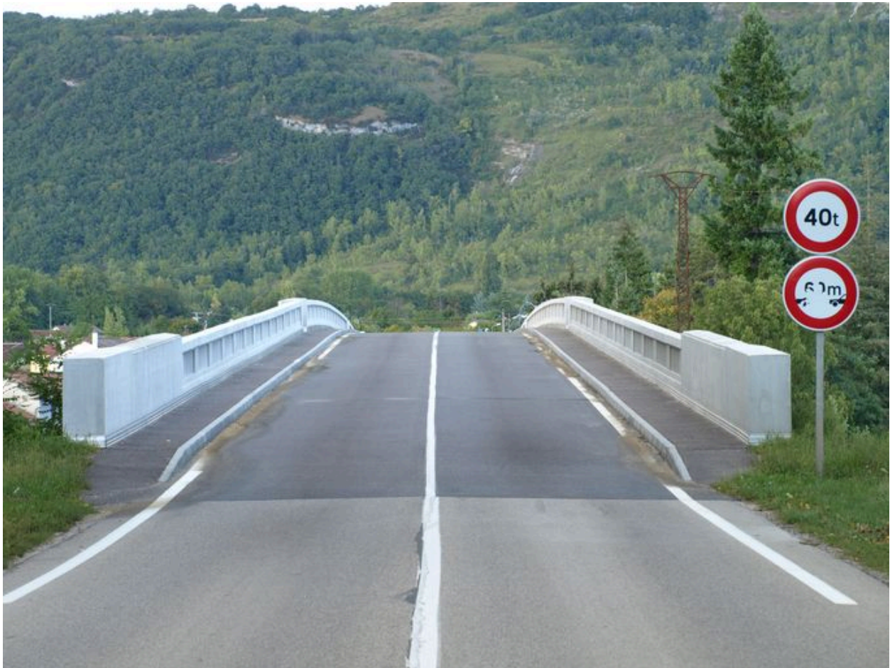
Chaussée (depuis la rive gauche)
