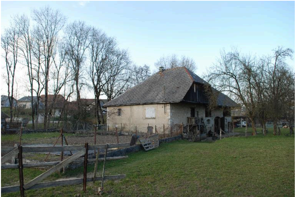
Vue d'ensemble lointaine de la ferme de trois-quarts avant droit.
