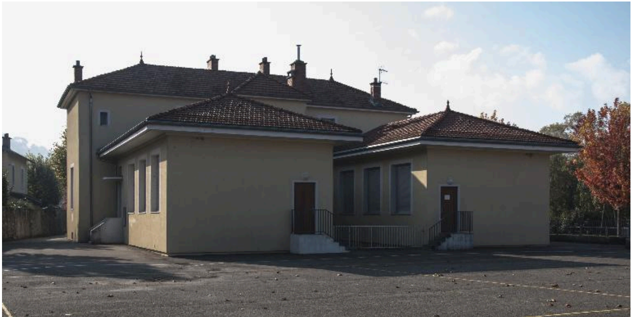
Vue depuis l'arrière
