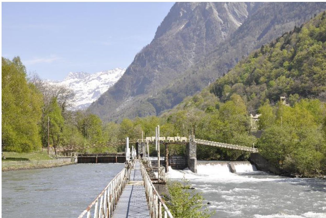
Vue d'ensemble du barrage
