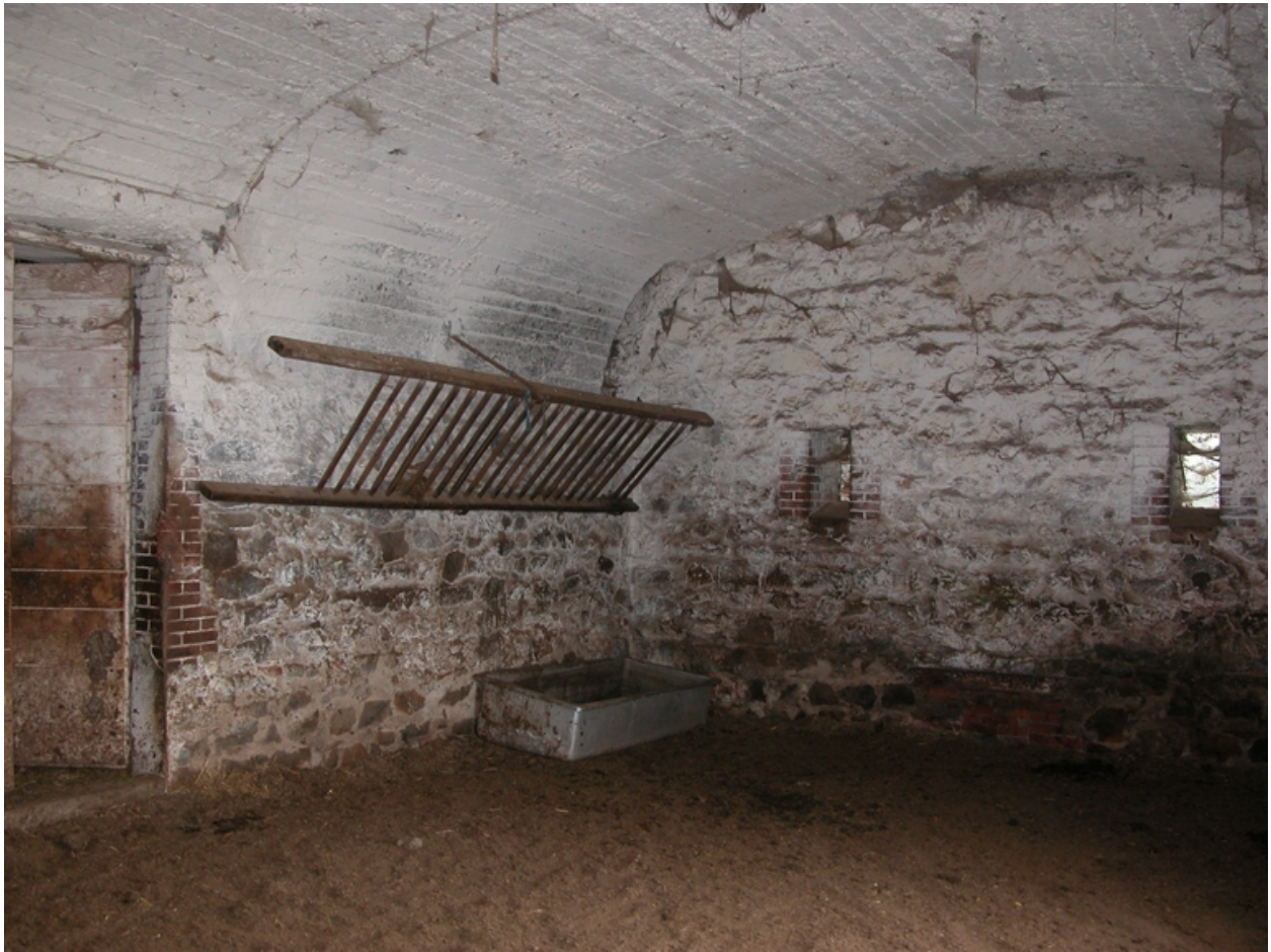
Vue intérieure : salle voûtée.
