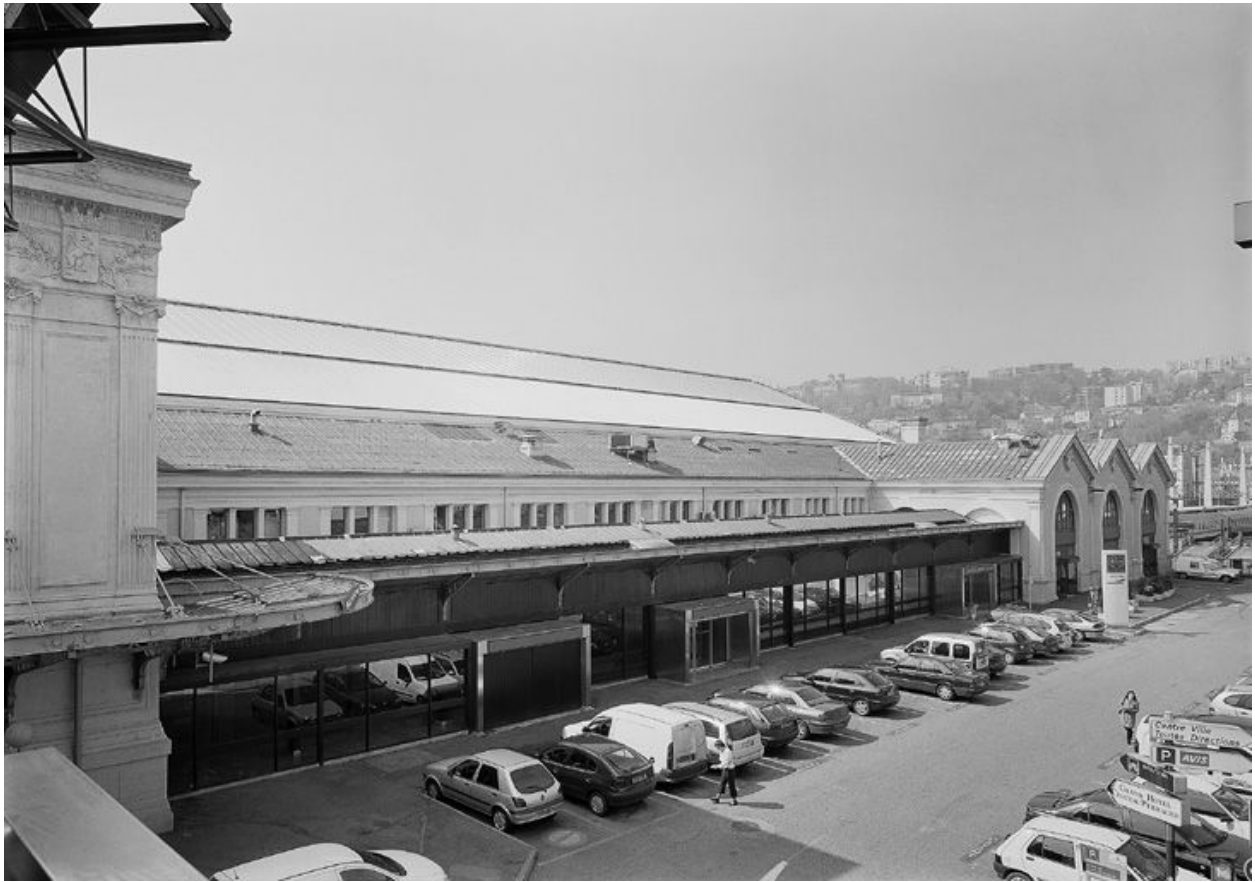
Le bâtiment-voyageurs : élévation nord, corps de bâtiments ouest
