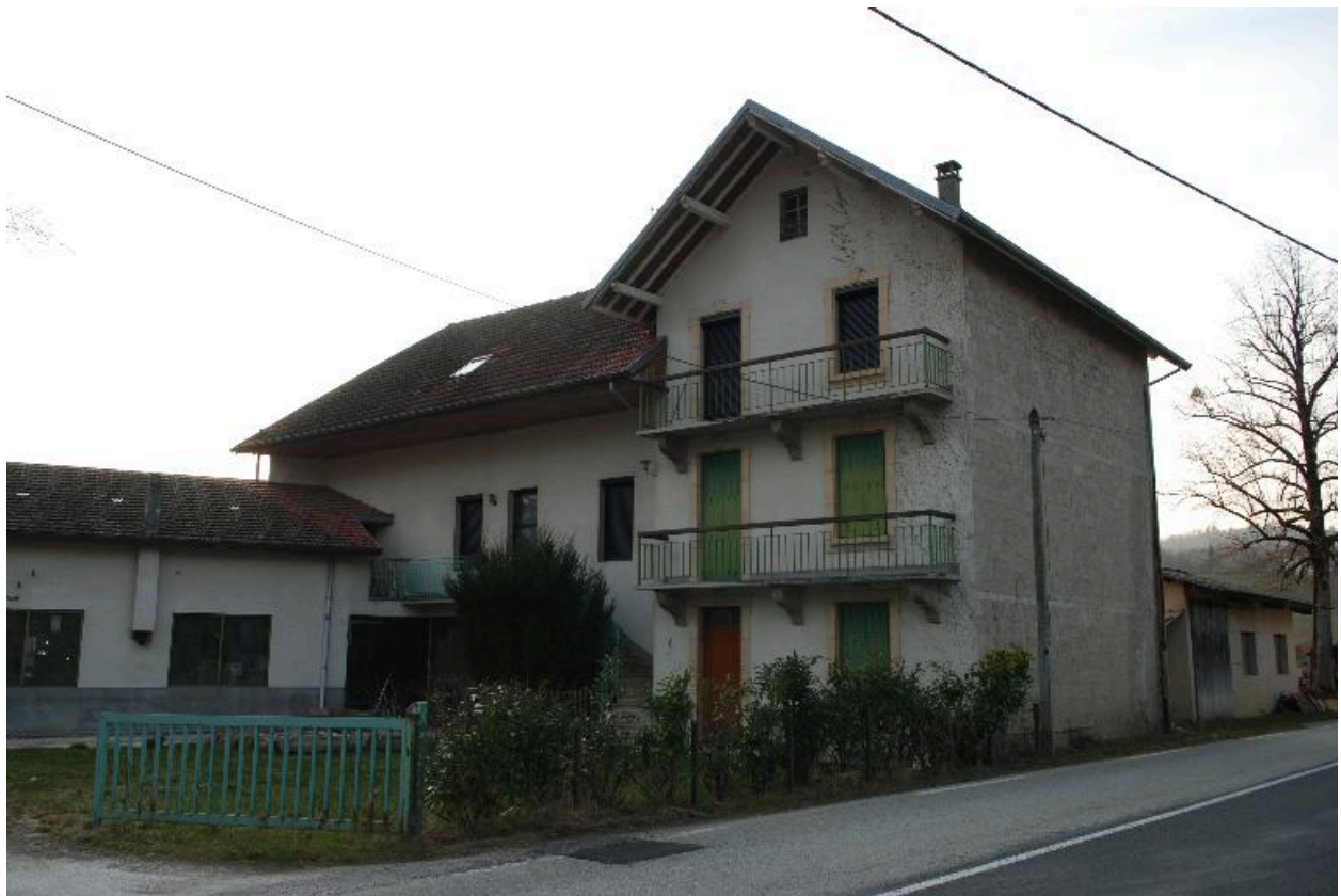
A4 398, Covasses (les), marbrier. Vue d'ensemble des bâtiments.
