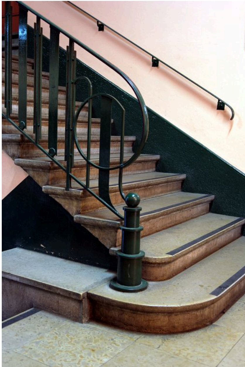
Escalier nord, détail de la rampe
