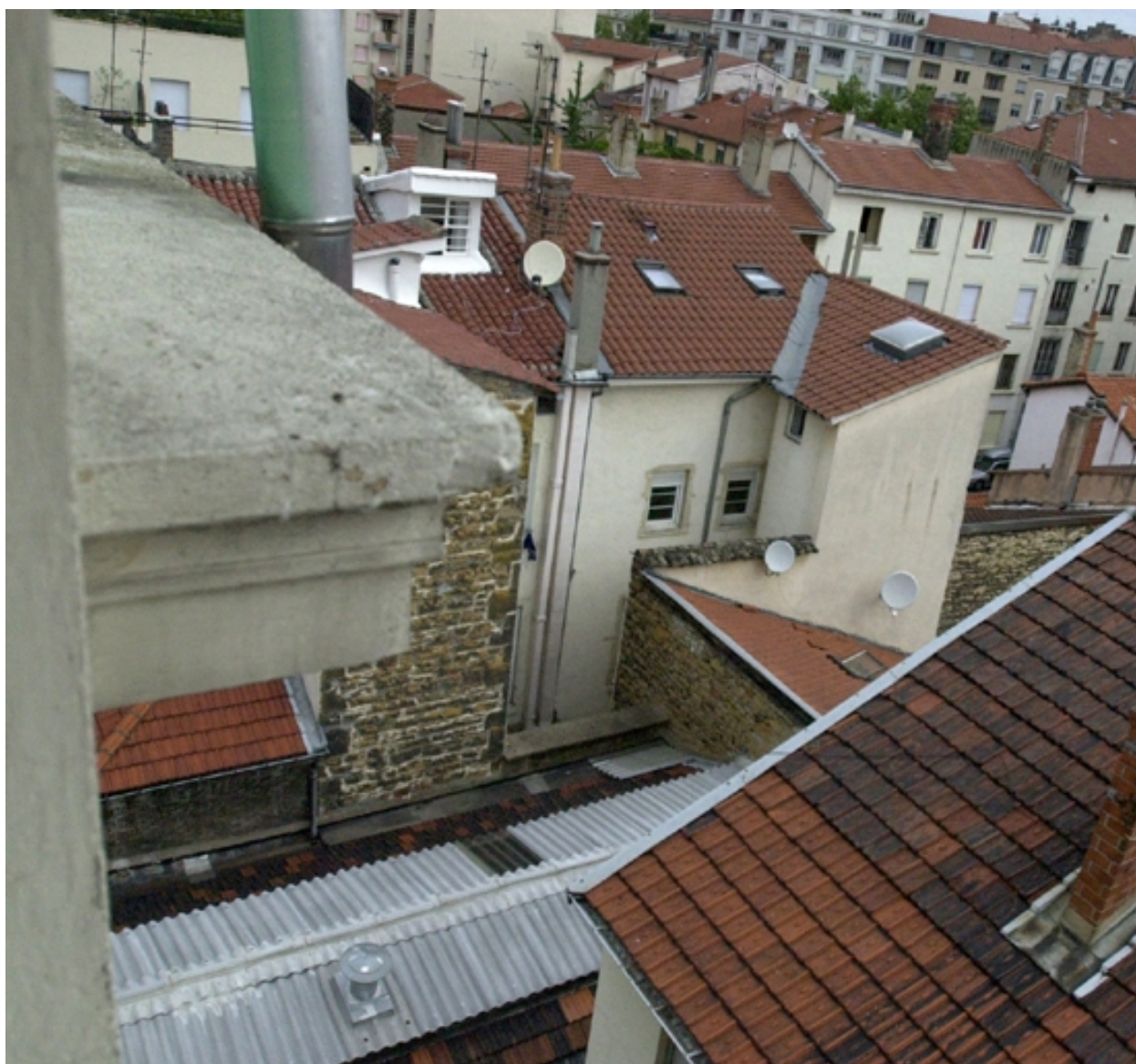
Vue des toitures
