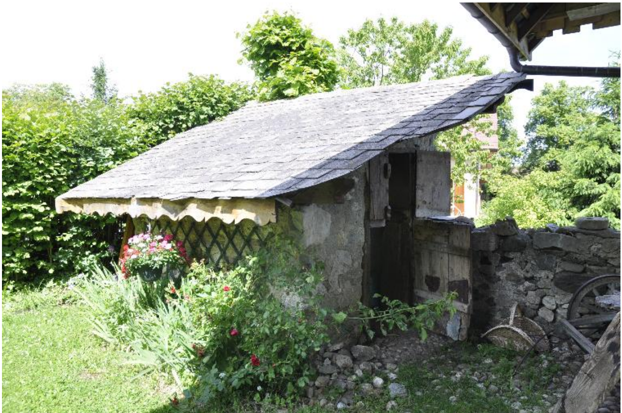
Vue de la loge à porc.
