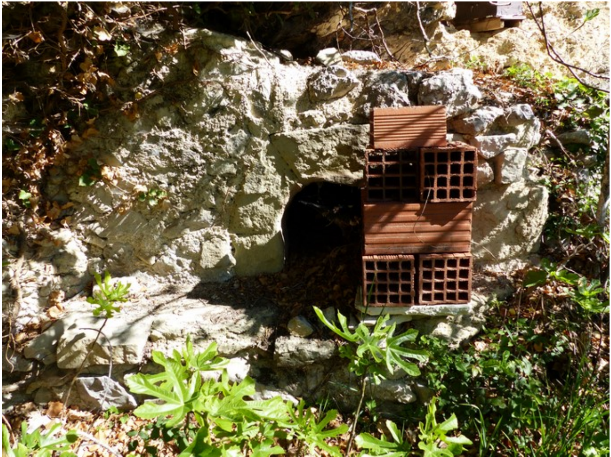
Four à pain. Vue d'ensemble.
