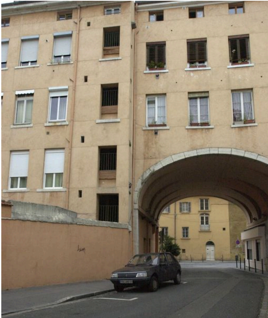
Elévation postérieure depuis la rue Saint-Michel à l'ouest : la cage d'escalier en saillie
