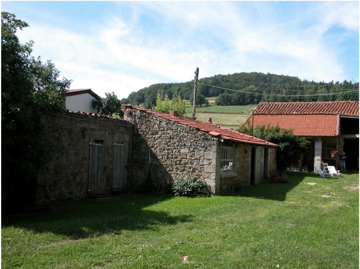
Vue du fournil-atelier-chaudière et de la porcherie.
