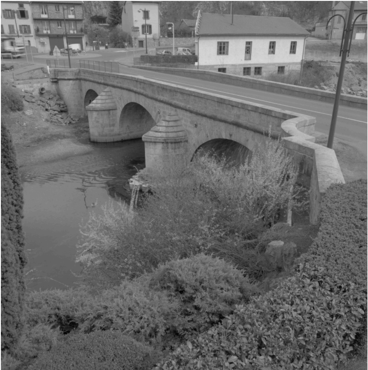
Vue du pont, de l'ouest.
