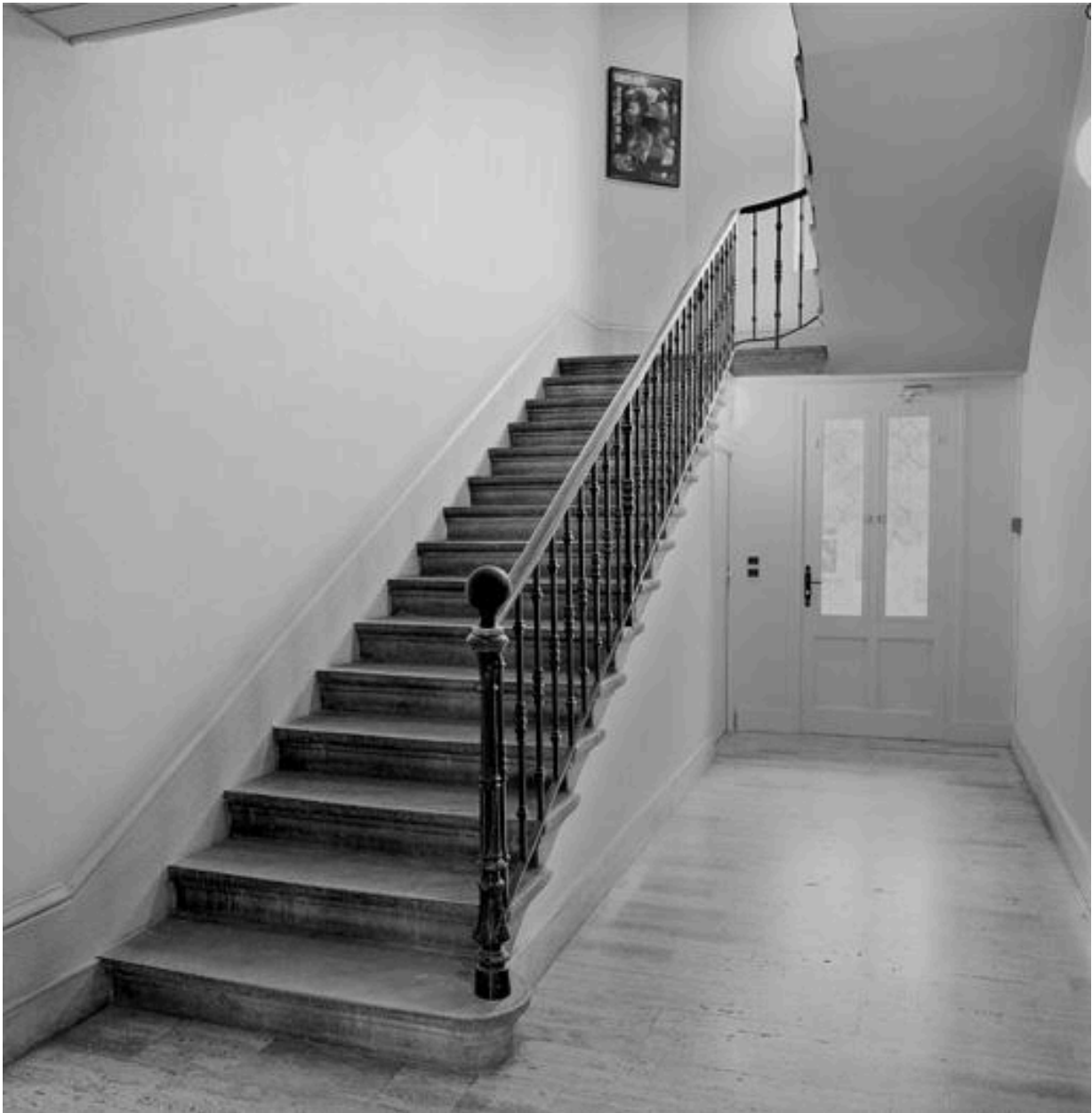
Escalier intérieur (bâtiment administratif)
