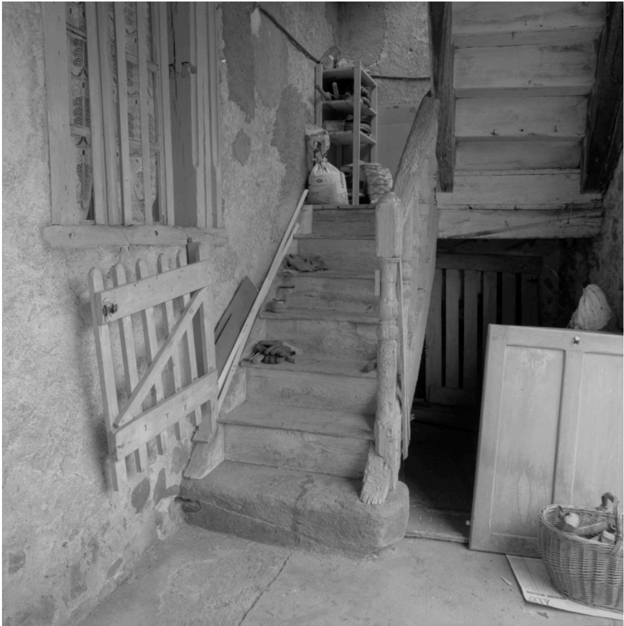
Départ de l'escalier de la galerie du corps logis du 16e siècle.
