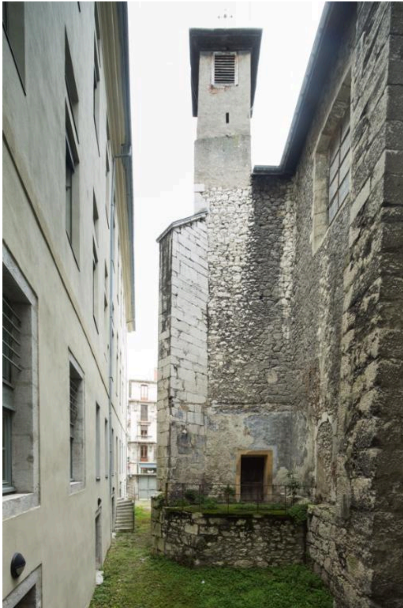
Espace de transition entre l'aile C et la chapelle. Vue prise depuis la galerie.
