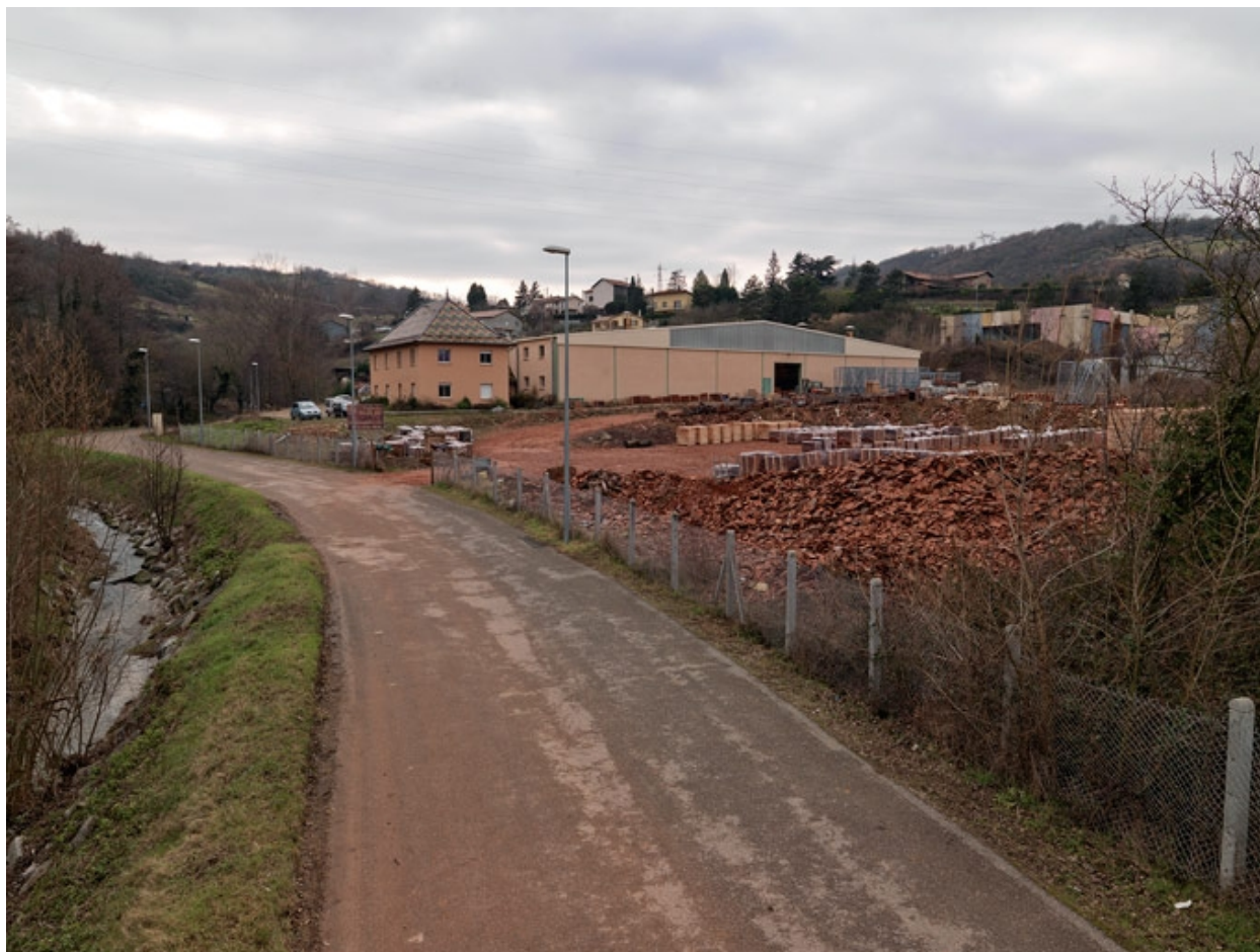
Vue d'ensemble de la nouvelle tuilerie Blâche
