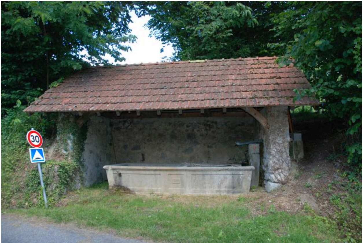
Vue du bassin couvert (fontaine, lavoir, abreuvoir ; 2017 D6 561).
