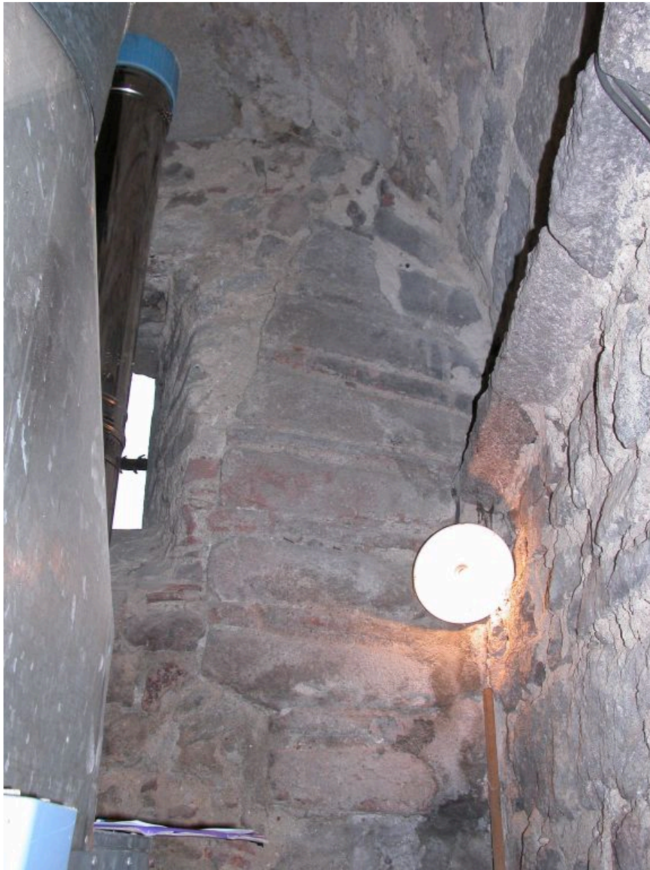
Chaufferie actuelle, angle sud-est, détail d'une arcade ancienne.
