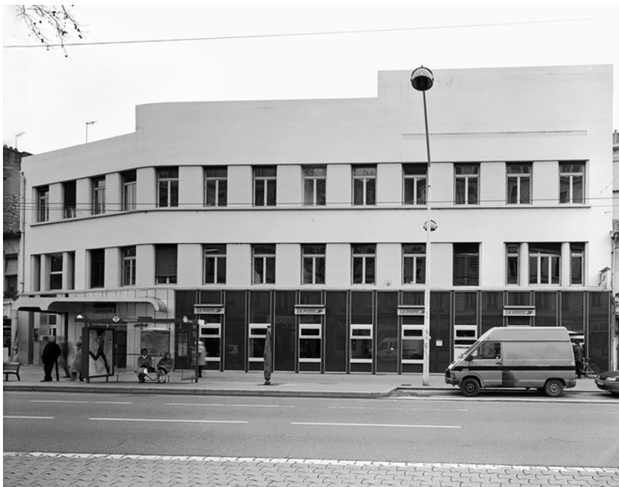
Vue générale ouest
