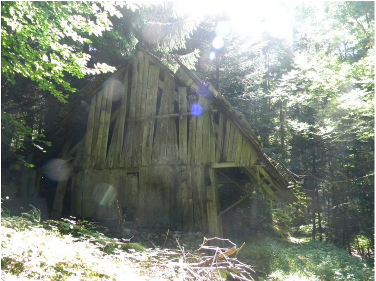
Ancienne grange abandonnée dans une zone de reforestation.
