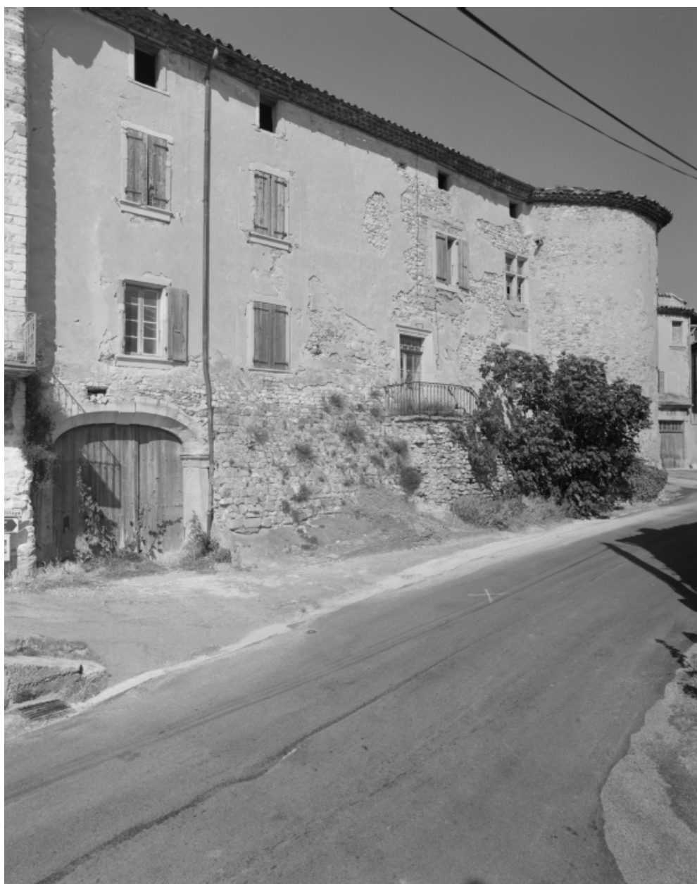
Façade sur rue de la maison cadastrée C 107, comprenant une tour ronde sur l'angle sud.
