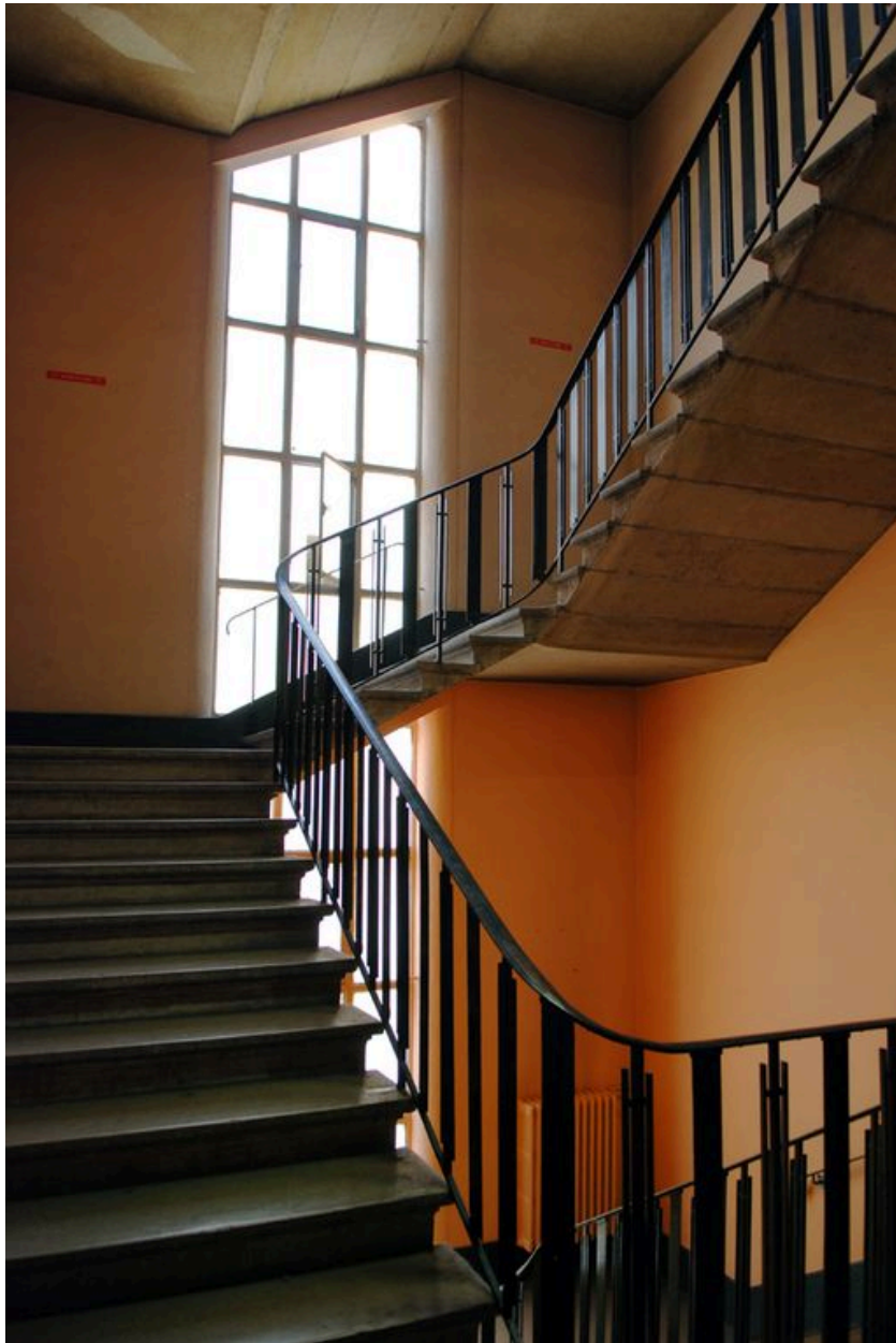
Escalier sud, détail d'une volée
